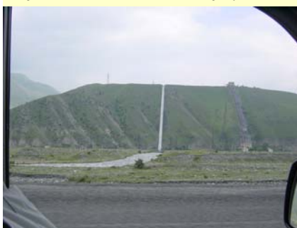
Aan de Ingoesjetische kant wordt waterkracht opgewekt
